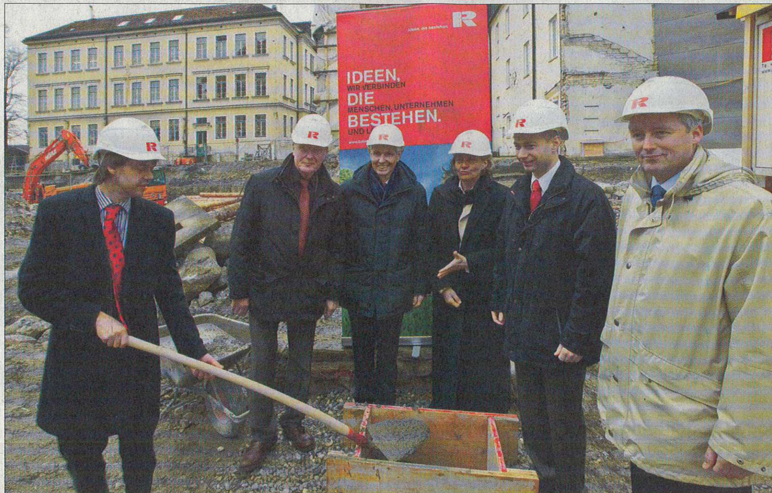
Der Grundstein für den Neubau an der Kalkhütte ist gelegt, darüber freuen sich (von links): Projektleiter Joachim Nägele, Ex-Landrat Eduard Leifert, Bauherr Walter-Heinz Rhomberg, Oberbürgermeisterin Petra Seidl, Landrat Elmar Stegmann und Architekt Wolff Stottele. Foto: Christian Flemming
