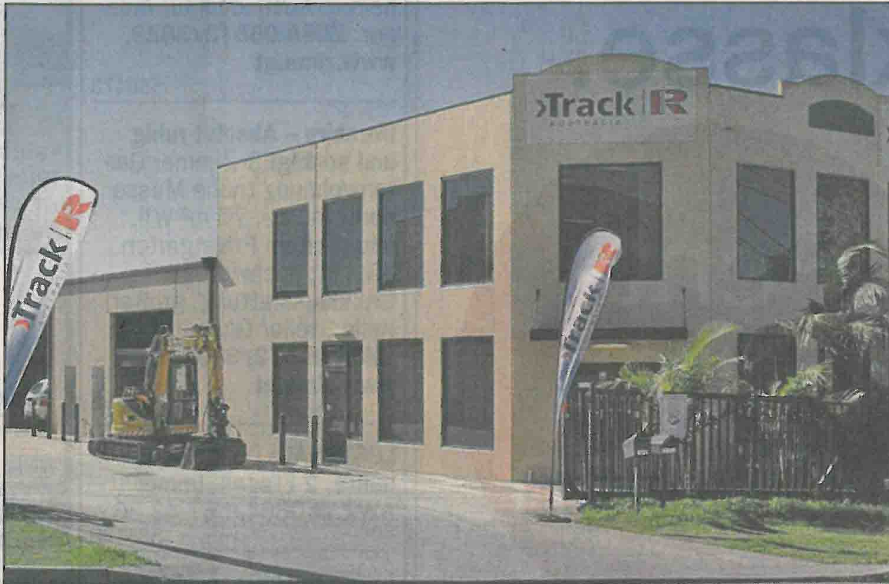
Neues Regional Office von Track Australia in Thornton in New South Wales: neue Drehscheibe für Rhomberg-Aktivitäten.
